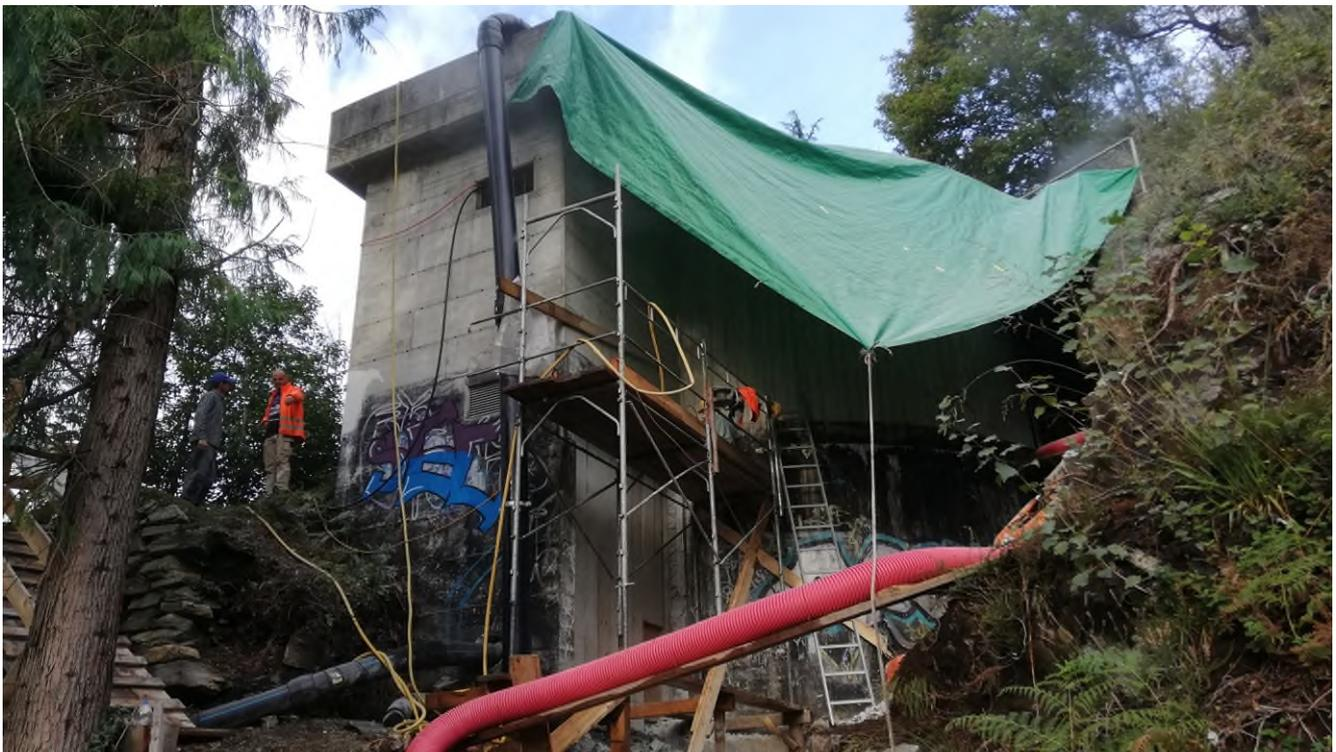
Foto 9 - Raccordo provvisorio alla rete di distribuzione esistente
