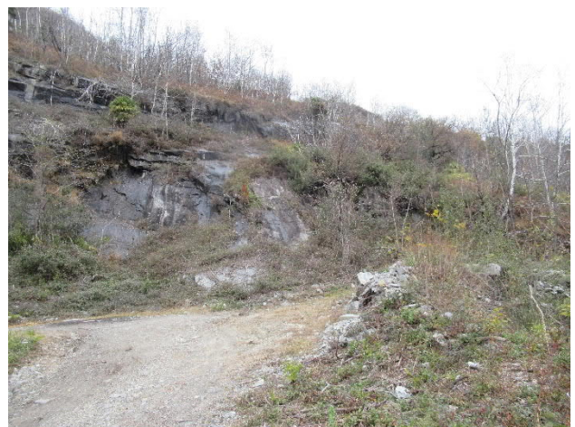
Curva di accesso al piazzale
