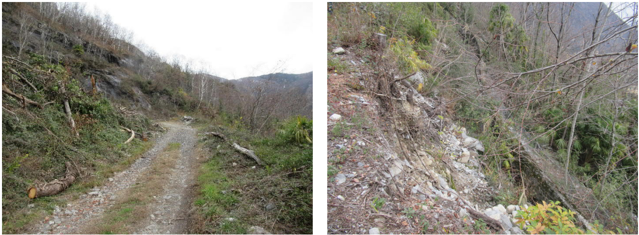
Figura 4 - Vista verso curva e scarpata curva
