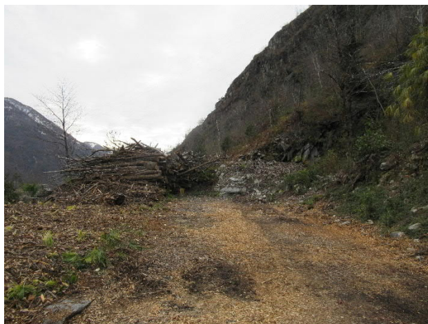
Piazzale di esbosco
