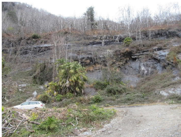
Curva di accesso al piazzale
