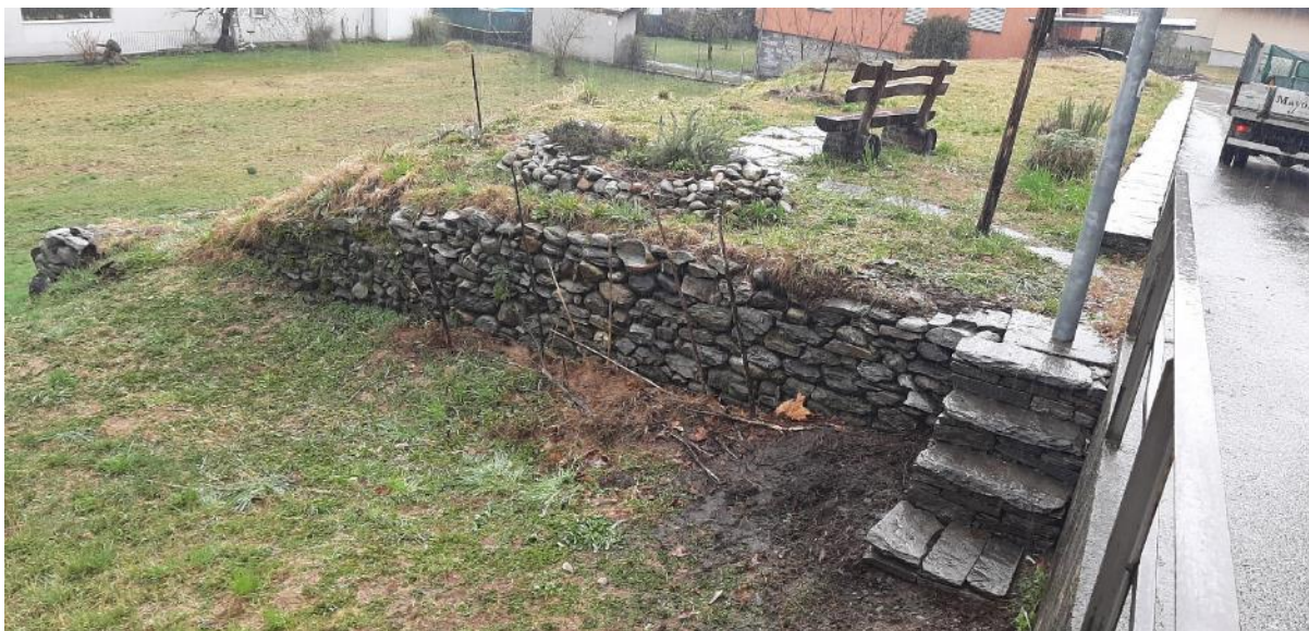
Scalinata a lavori ultimati e pioggia battente.
